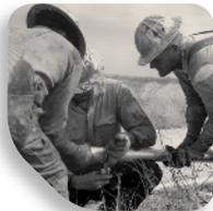
El ranurado cambió por completo la industria del tendido de tuberías al crear un método rápido y sencillo de ensamblar las uniones. Ahora es posible ranurar rápidamente la tubería con un corte y luego conectarla en forma segura con un cople Victaulic. El ahorro de tiempo y trabajo trajo consigo un espectacular aumento de la productividad.
